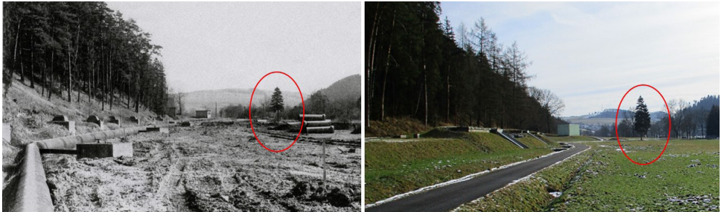
Obr. 8 • První snímek je pořízen při stavbě II. brněnského vodovodu (1974). V pravé části za hromadou potrubí je dům u kterého stojí smrk. Tento smrk je vidět i na současném snímku. Zdroj historické fotografie: www.muzlov.cz .
